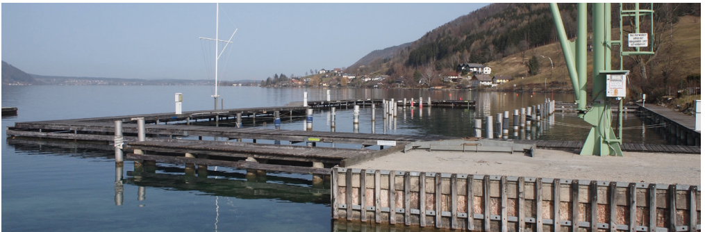
Illustration 2: Steganlagen am Attersee: Hebekräne, Stege und Bootsliegendeplätze gehören an vielen Seen zur selbstverständlichen Infrastruktur. Auch sie tragen zur Privatisierung und Kommerzialisierung bei. Quelle: Judith Leitner 2021
