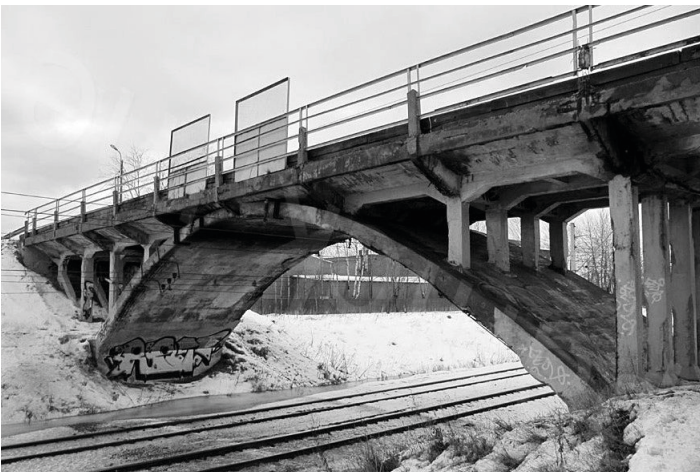
Illustration 1: Brücke für die Oranienbaumer Elektrische Eisenbahn, Robert Maillart, 1913.
