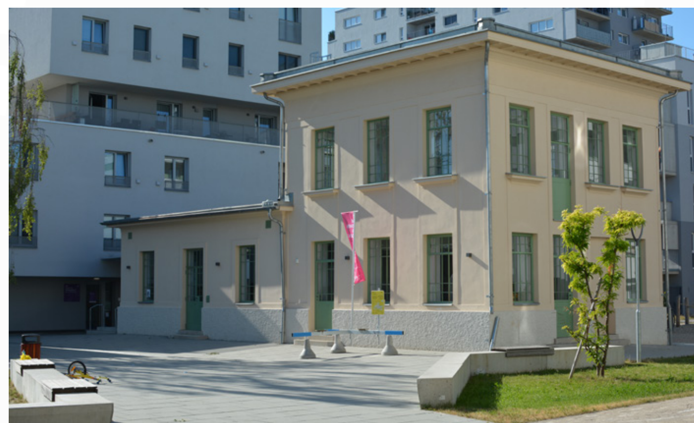
Bildnach: Bauplatzübergreifende Gemeinschaftsräume in Neu Leopoldau (© Ruth Högler 2022)
