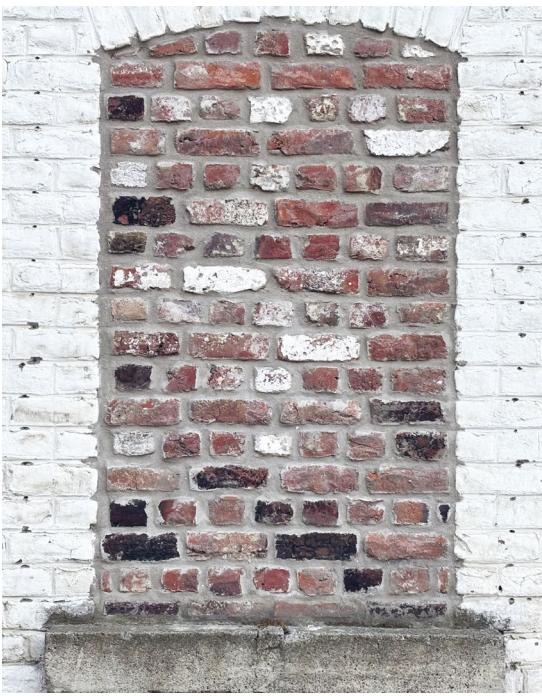
Alte Merkmale des historischen Gebäudes sind auch heute noch erkennbar. (Foto: Gruppe COOP Brüssel, 2025)
